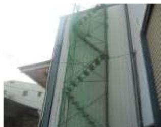
← 內爬梯式施工架
